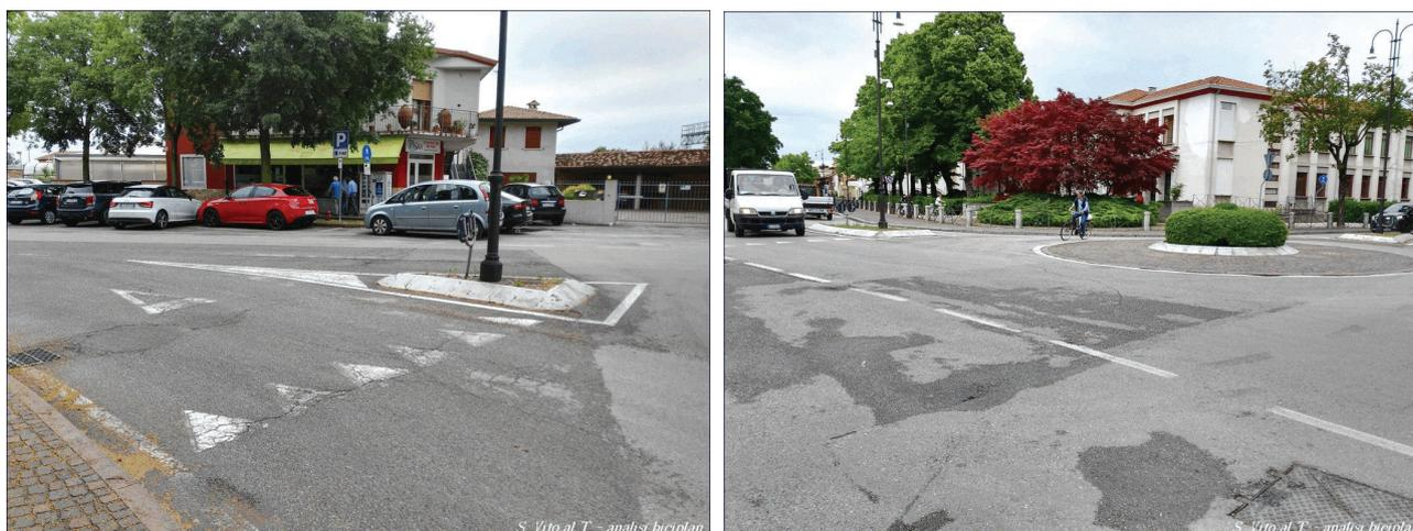
Figg. 13 - 14– Rotonda tra via Stazione e via Patriarcato: questa discontinuità è difficilmente superabile con una ciclabile in sede propria, per cui si ritiene necessaria una revisione del nodo nel senso della creazione di uno spazio condiviso
