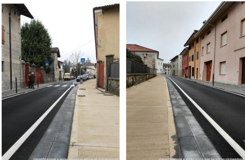
Figg.12a, 12b - Soluzione con percorso ciclopedonale da un lato e marciapiede dall’altro; la tipologia ciclopedonale è adatta quando il livello di frequentazione delle due utenze non è elevato
