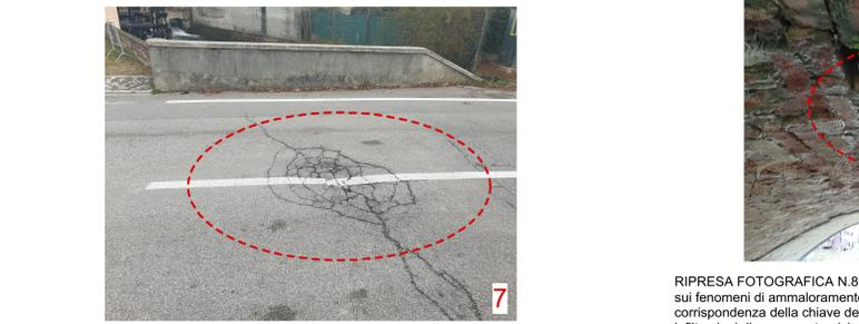
RIPRESA FOTOGRAFICA N.7: immagine della parte estradosale del ponte con primo piano sui fenomeni di ammoramento - degrado locale della carreggiata visibili nelle fessurazioni della pavimentazione stradale e nel cedimento in corrispondenza della chiave dell'arco
