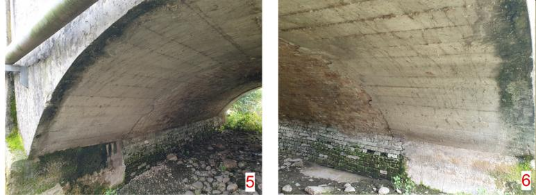
RIPRESA FOTOGRAFICHE N.5-6: immagini dell'arco alle imposte con primo piano sull'ampliamento della sede stradale realizzato su ambo i lati con struttura in calcestruzzo armato
