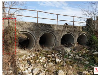
RIPRESA FOTOGRAFICA N.3: immagine del prospetto a valle del ponte con primo piano sulla fessurazione del paramento murario in calcestruzzo di sostegno del terrapieno stradale
