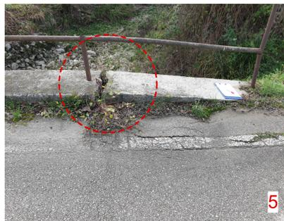
RIPRESE FOTOGRAFICHE N.4-5: primo piano sulla fessurazione del paramento murario in c.a. di sostegno del terrapieno stradale localizzata in corrispondenza della spalla di appoggio
